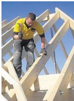
Auf dem Dach kennen sich die Mitarbeiter der Sowade GmbH aus.
